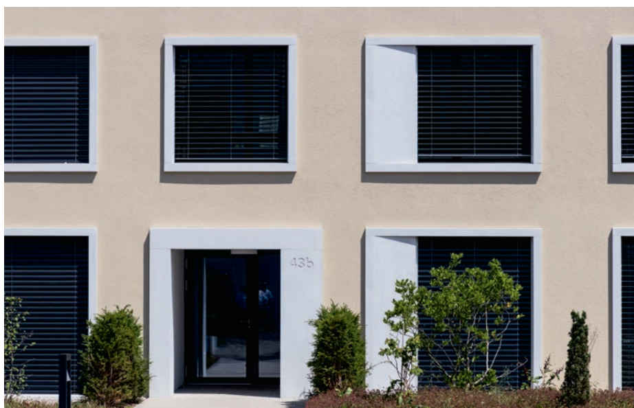
Die attraktiven Fensterumrandungen aus Glasfaserbeton des Baufelds E geben eine edle Note.
