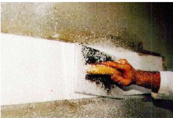
RSS EPS-Einlage mit Schleifbrett planschleifen
