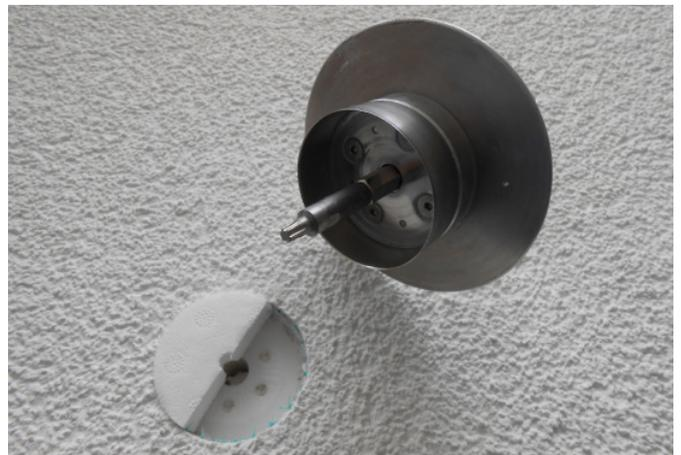
Mit dem STR-Tool 2GE 120726 wird das Setzen der versenkbaren Dübel (D1561) durchgeführt.
