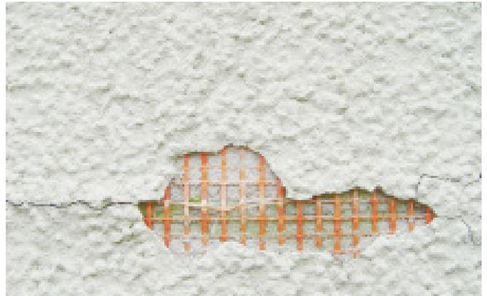
Risse im Plattenstoss mit freiliegendem Gewebe
