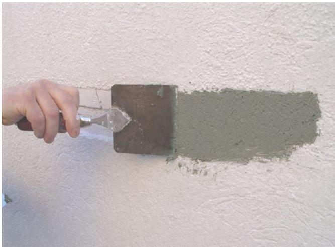
Die Rissbrücke wird mit RSS 2K Riss-Spachtel ausgefüllt und auf das Deckputzniveau abgezogen.
