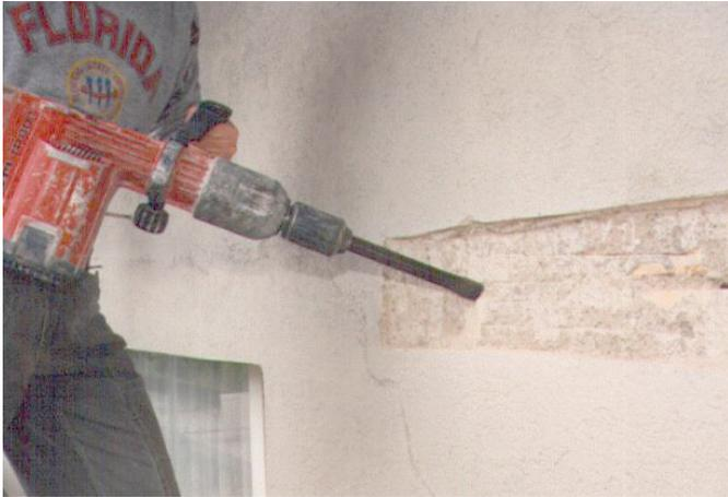
Deck- und Grundputz bis auf das Mauerwerk abtrennen
